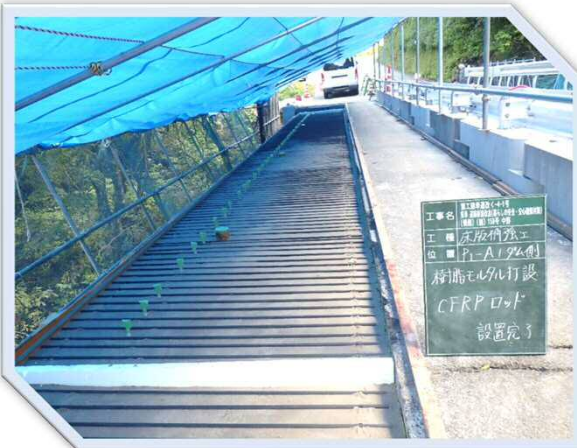
【生産性向上 床版補強工】
