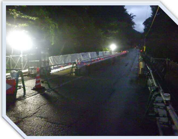
【安全対策 LEDバルーンライト等設置】
